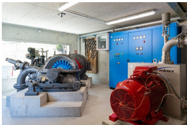
Trinkwasserkraftwerk auf dem Parkplatz Fadail mit der ersten Stromerzeugungsanlage auf der Lenzerheide
